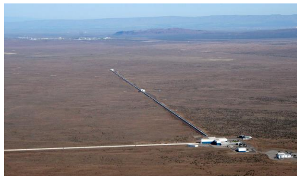
Рис. 6. Гравитационно-волновой детектор в Ханфорде — один из двух детекторов обсерватории LIGO. Изображение из статьи M. Mitchell Waldrop, 2016. The hundred-year quest for gravitational waves — in pictures
